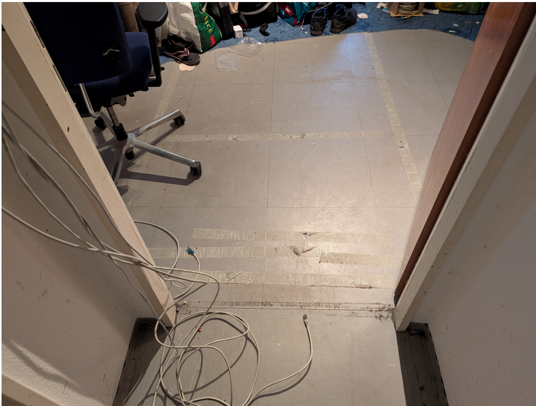
Figure 13: Durchnässte Teile des Wohnzimmerteppichs entfernt
