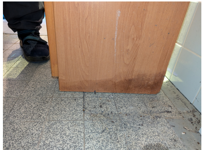
Figure 11: Abwasserschaden an Badkommode, Ansicht Seite
