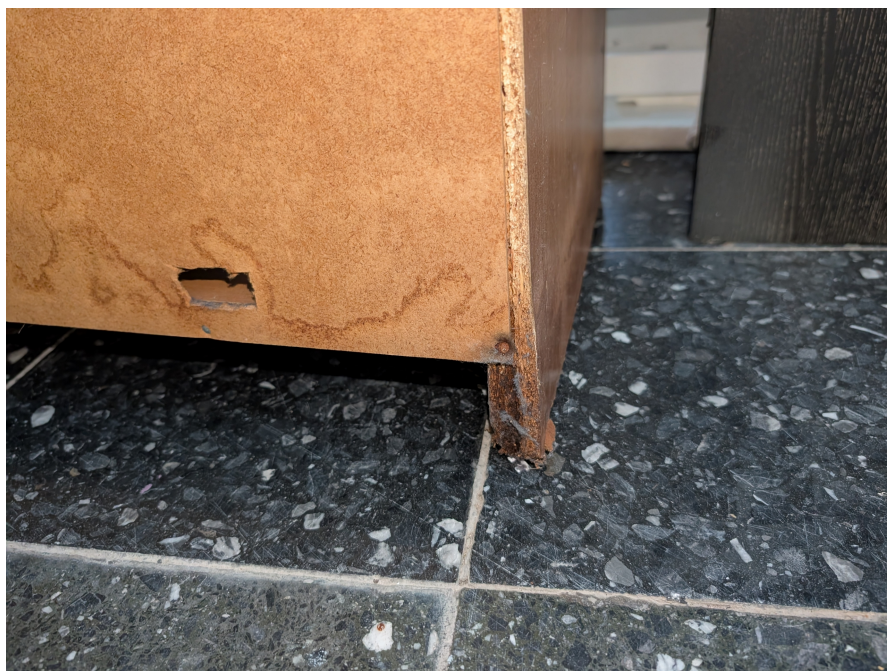
Figure 12: Abwasserschaden an Badkommode, Ansicht Hinten
