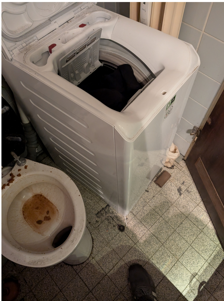
Figure 20: Ansicht von mit Fäkalien bedeckter Toilette und auf in Abwasser getränkter Isoliermatte stehender Waschmaschine
