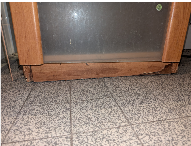
Figure 10: Abwasserschaden an Badkommode, Ansicht Vorne
